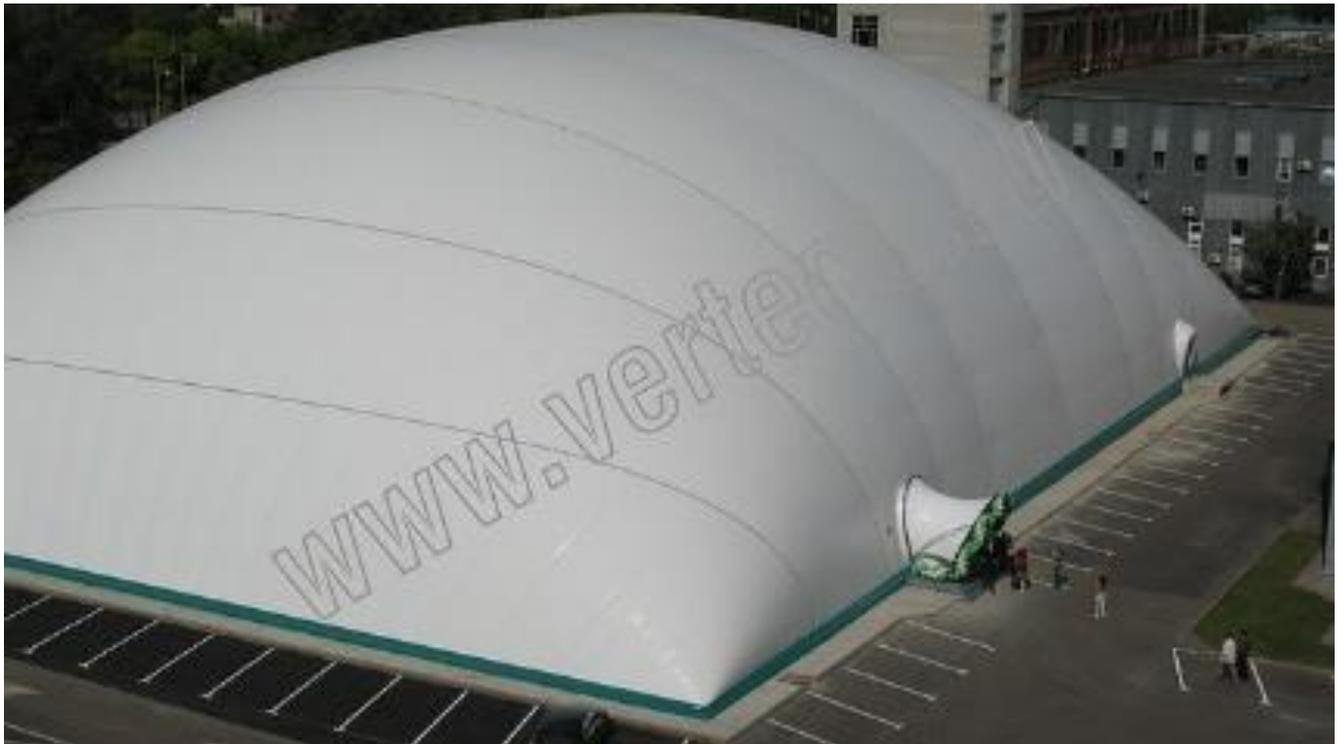
Рисунок 1.2 Воздухоопорное покрытие футбольного стадиона в Краснодаре, спроектированного и возведенного ООО «ПСБ «Вертеко»
