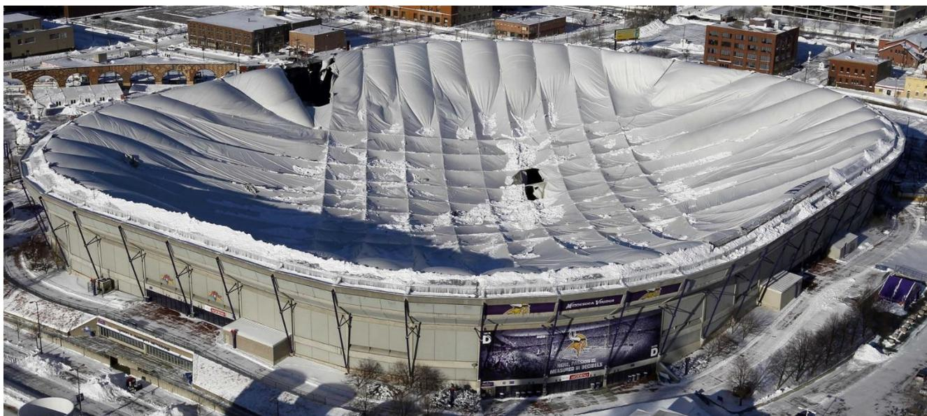
Рисунок 1.5 Обрушение покрытия стадиона *Metrodome* в 2010 году
